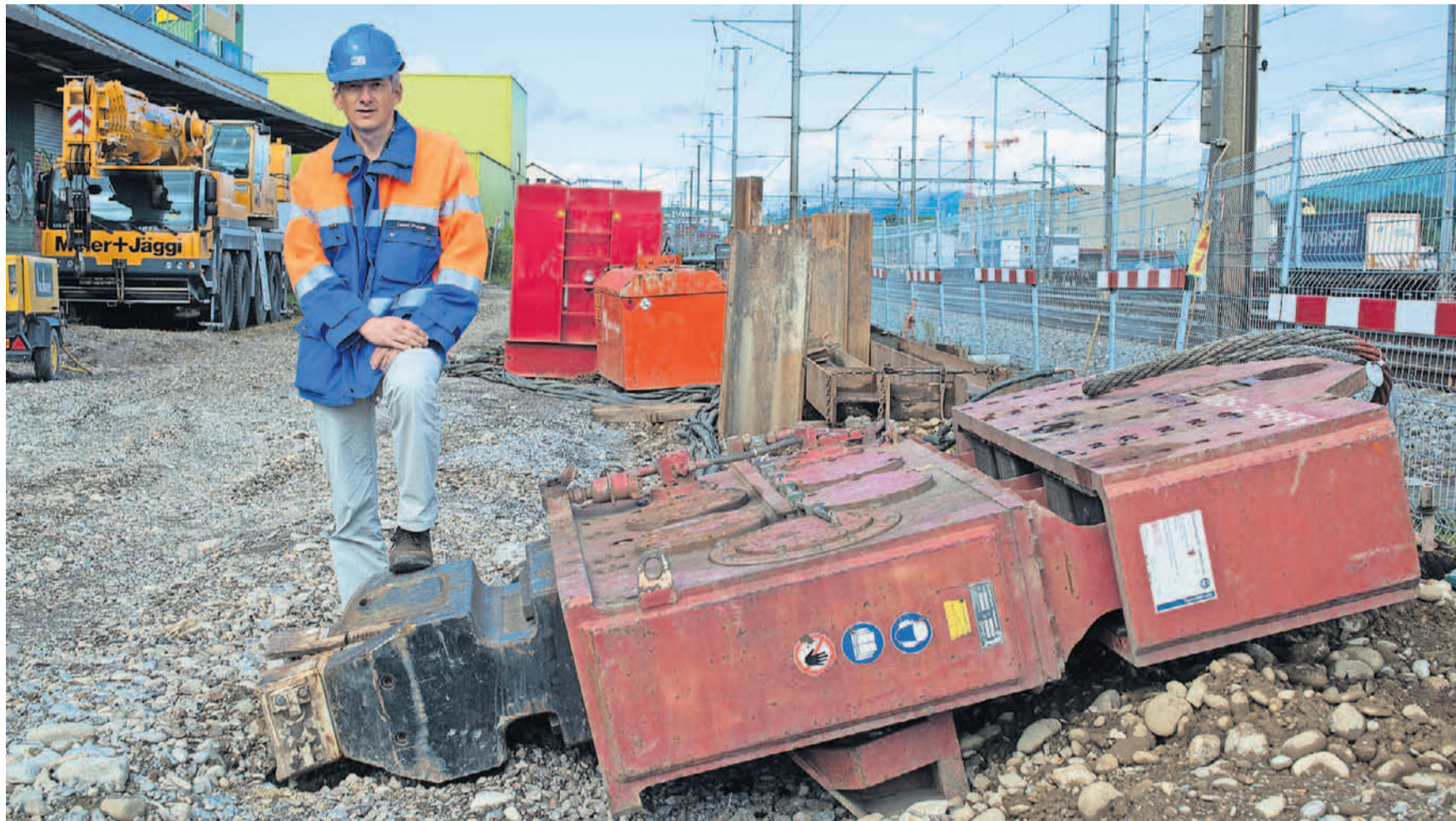
David Probst steht mit einem Bein auf dem Vibrationsbär, der die Spundwandelemente zur Absicherung der Baugrube in den Boden einrammt. Hinter ihm steht bereits ein Stück Spundwand.
